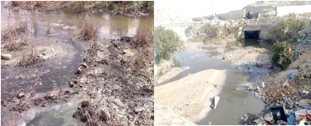
مكان تجمع مياه الصرف الصحي بمدينة أم العرائس 1
