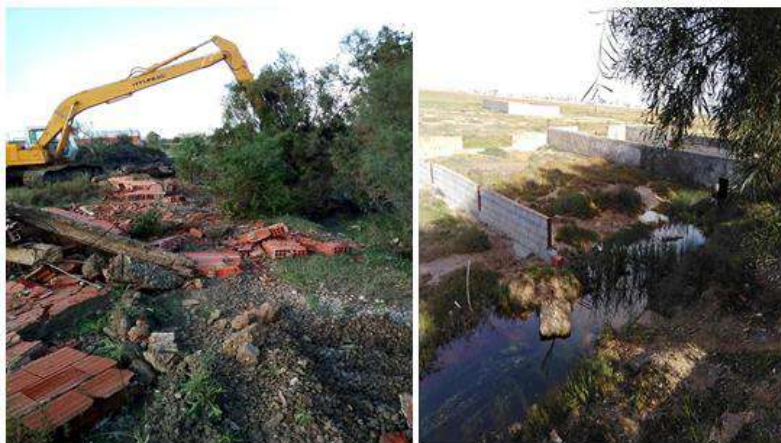
Photo.4 : Démolition des constructions anarchiques
