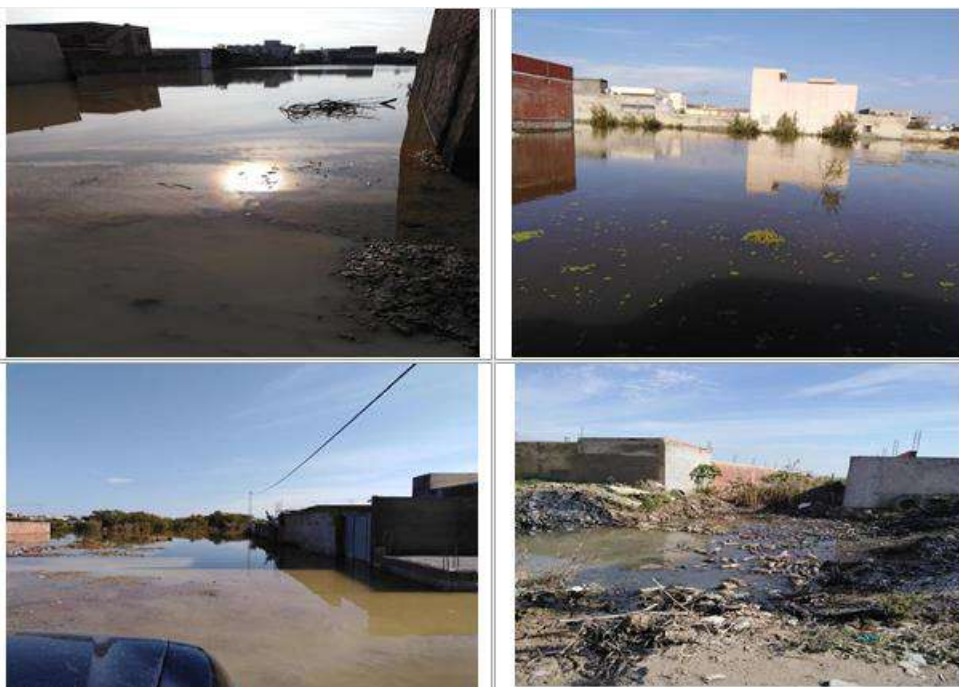
Photo. 2 : Constructions anarchiques au détriment de cours d'eau
