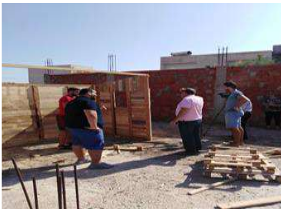
Photo. 7 : initiative de construction d'une station de bus
