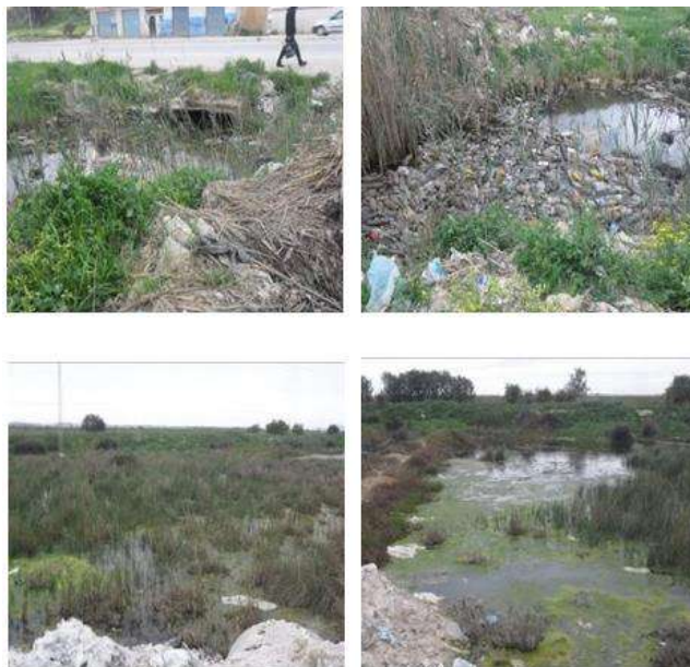
Photo .3: Stagnation des eaux pluviales
