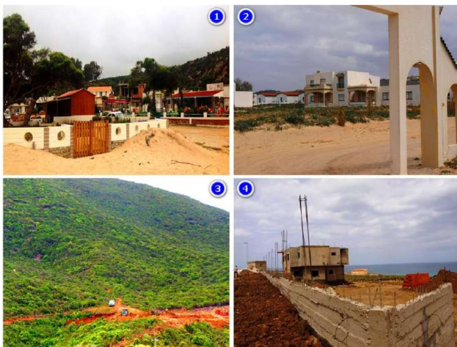
1 : Résidences touristiques non réglementaires sur le DPM à Cap Serrat- 2 : Résidence Iris : une forme de tourisme réglementaire- 3 : Destruction de la végétation naturelle par un bulldozer et début d'un chantier- 4 : construction sur front de mer à Dar El Jannah
