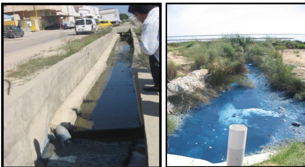
Eaux industrielles déversées dans les canaux menant au golfe de Monastir
