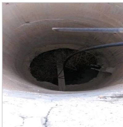
Puit de surface asséché
