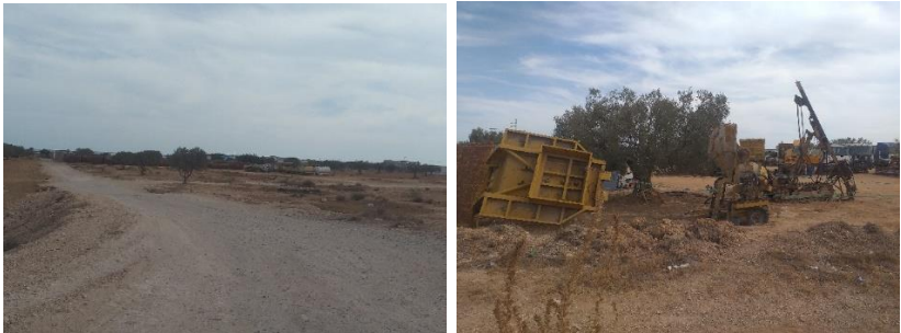
Photographie 2 : dépôt de ferraille en pleine ceinture d'oliviers (situé à 16 kilomètres du centre-ville). - © Ines Naimi (novembre 2021)
